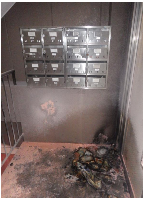
エントランス部分の状況
