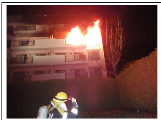
建物火災延焼中の状況
