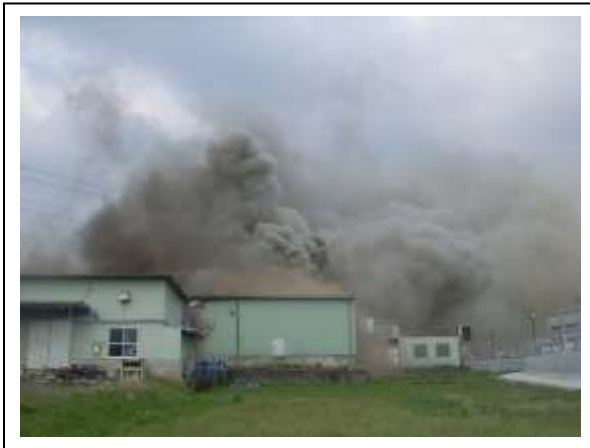
建物火災の発生状況
