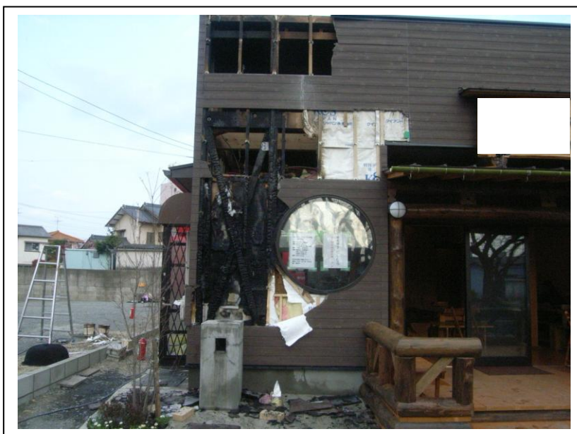
写真3-1-4 「焼損した外壁の状況」
