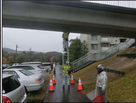
写真-3.2 専門業者による点検状況②
