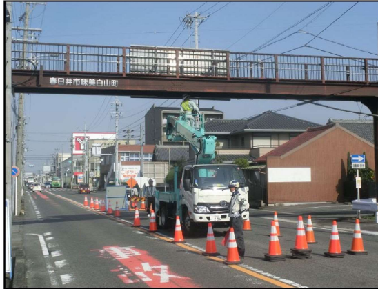
写真-3.1 専門業者による点検状況①
