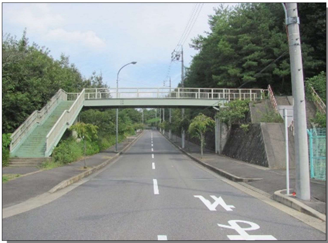
玉野台北歩道橋
