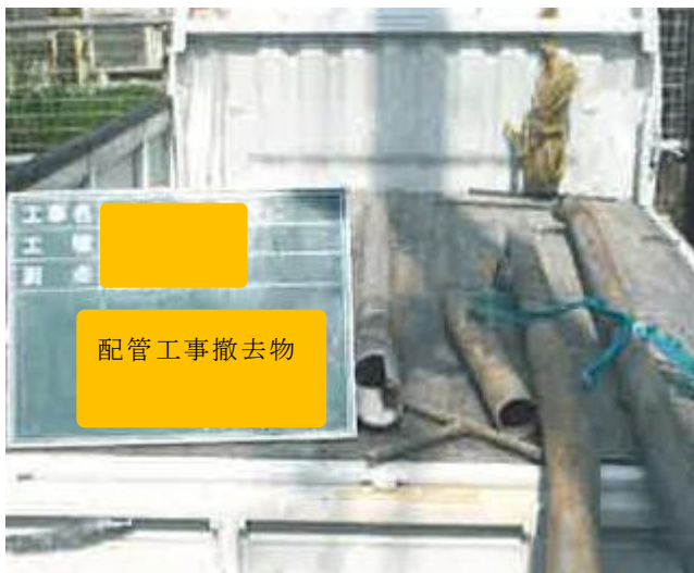
撤去した配管の積み運び状況
