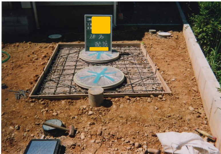
上部配筋状況
