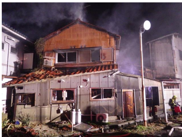
建物火災延焼中の状況
