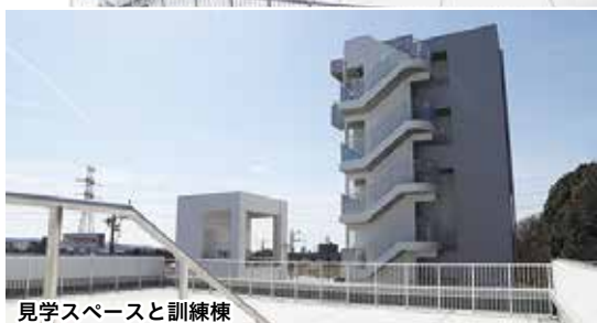
見学スペースと訓練棟
