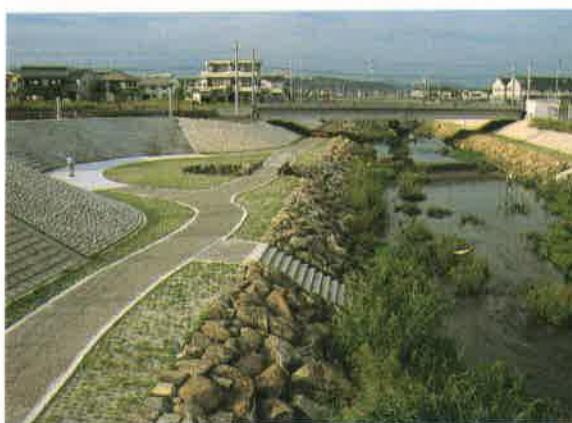
・内津川放水路を生かし、住宅地にうるおいのある空間を提供する。
