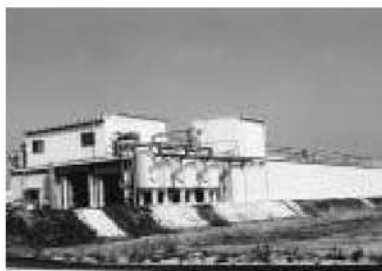
▲排水処理施設
