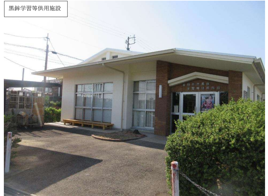
黒銚学習等供用施設
