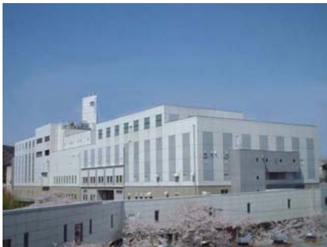
クリーンセンター第2工場棟
