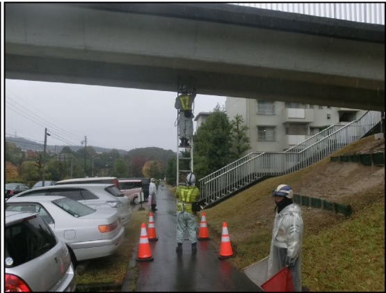
写真-3.2 専門業者による点検状況②
