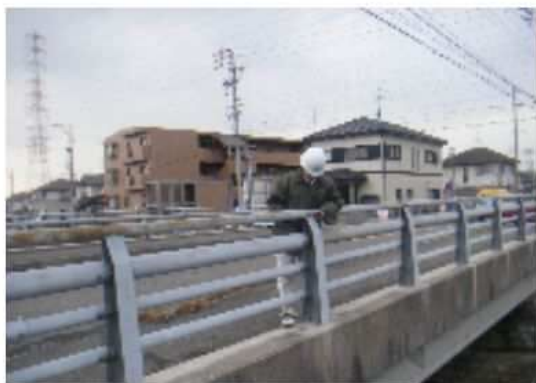
写真-3.3 道路パトロール状況①
