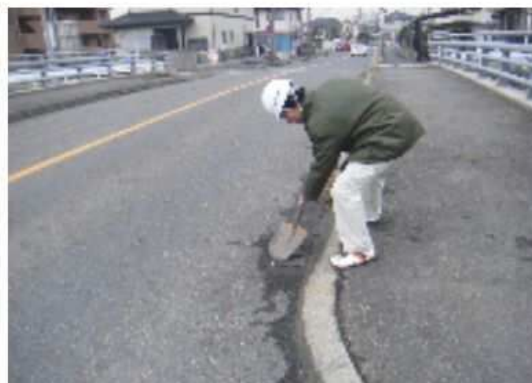
写真-3.4 道路パトロール状況②
