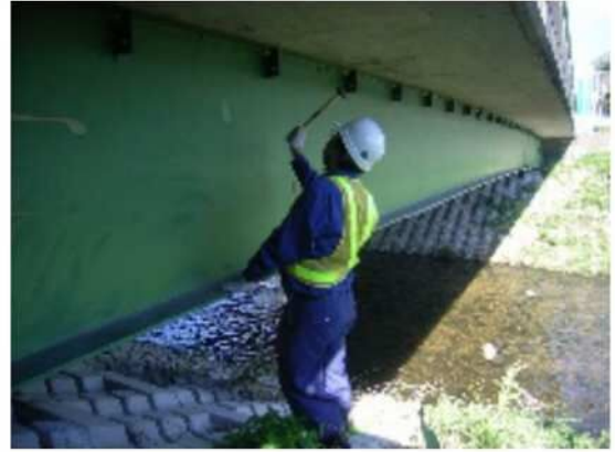
写真-3.2 専門業者による点検状況②
