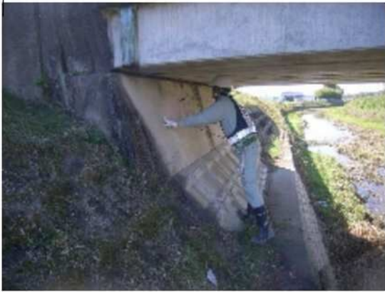
写真-3.1 専門業者による点検状況①
