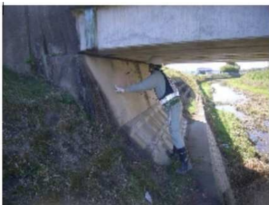
写真-3.1 専門業者による点検状況①
