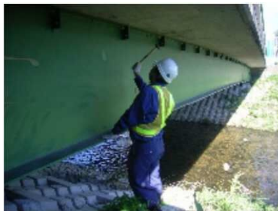
写真-3.2 専門業者による点検状況②
