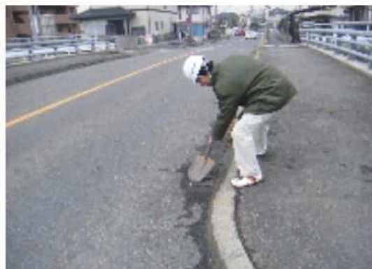
写真-3.4 道路パトロール状況②
