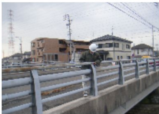
写真-3.3 道路パトロール状況①
