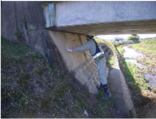
写真-3.1 専門業者による点検状況①
