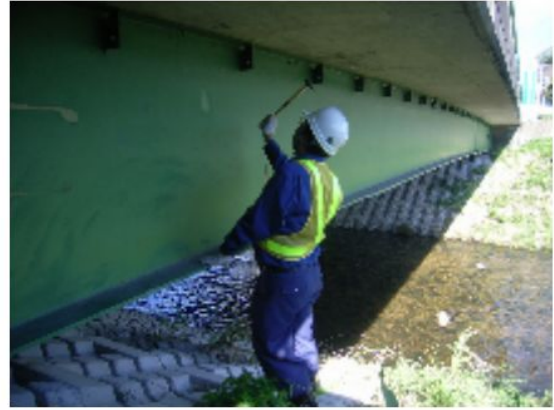
写真-3.2 専門業者による点検状況②
