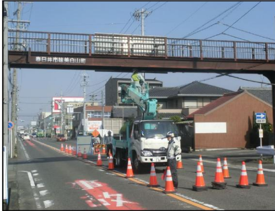
写真-3.1 専門業者による点検状況①
