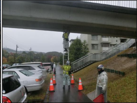
写真-3.2 専門業者による点検状況②
