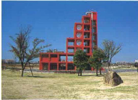
落合公園 水の塔
