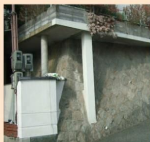
張出し床版付擁壁
