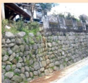
玉石積み擁壁
