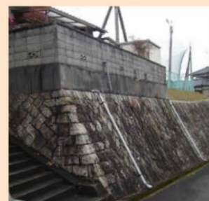
増し積み擁壁
