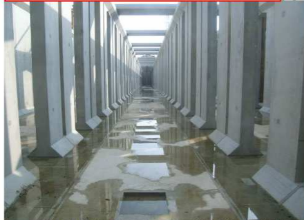
A1-1-6 大手小学校調整池整備(浸水対策)
