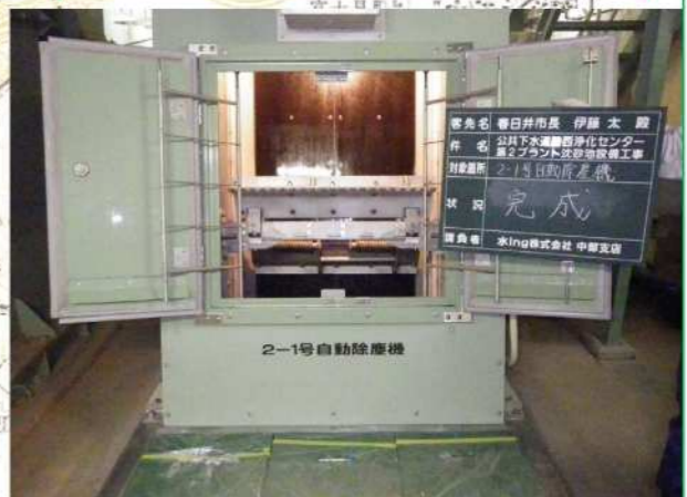
A1-2-2 勝西浄化センター改築更新工事(水質保全)
