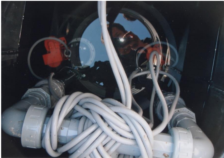
ポンプ槽状況
