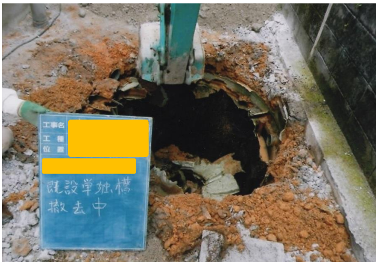
撤去中の状況
