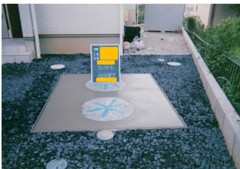
工事完成状況
