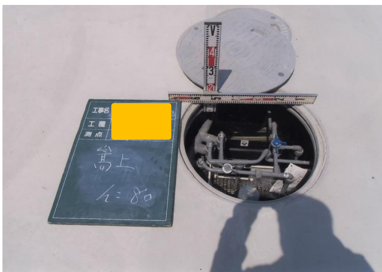
本体嵩上げ状況
