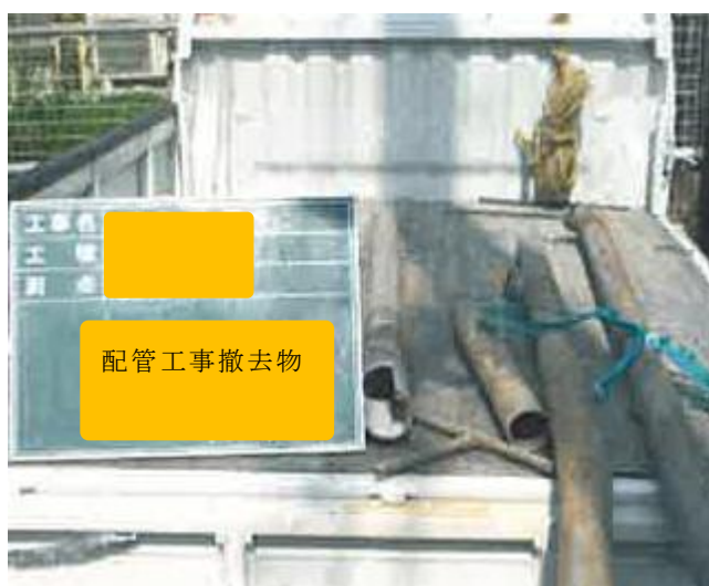
撤去した配管の積み運び 状況
