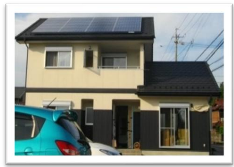
【例】建物の全景写真
