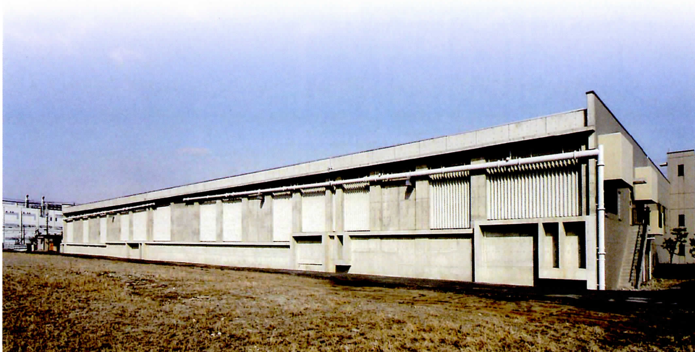
南部浄化センター水処理棟(2系)外観
