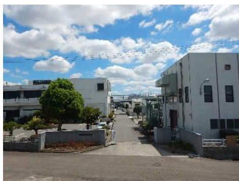
勝西浄化センター
