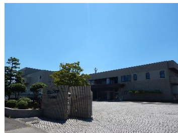
南部浄化センター
