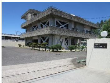
高蔵寺浄化センター
