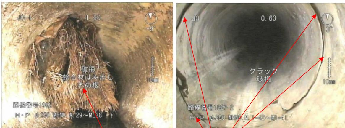
汚水接続ますから下水道本管への接合部より、木根が浸入している
