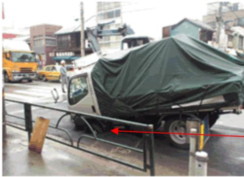
管きよの老朽化による破損に起因して、道路が陥没し、車両がはまった状況。
