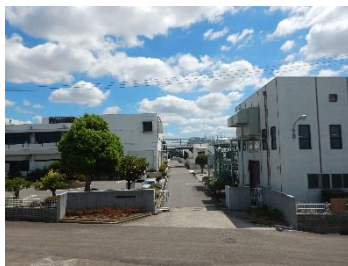
勝西浄化センター
