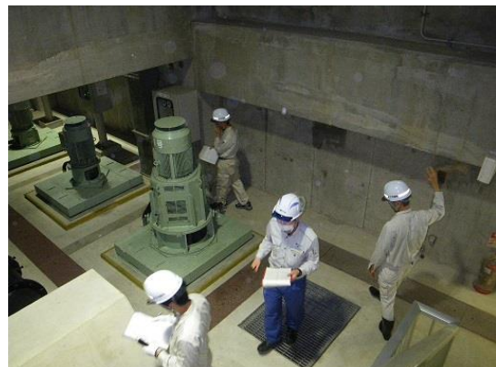
【下水道 BCP 訓練の様子】
