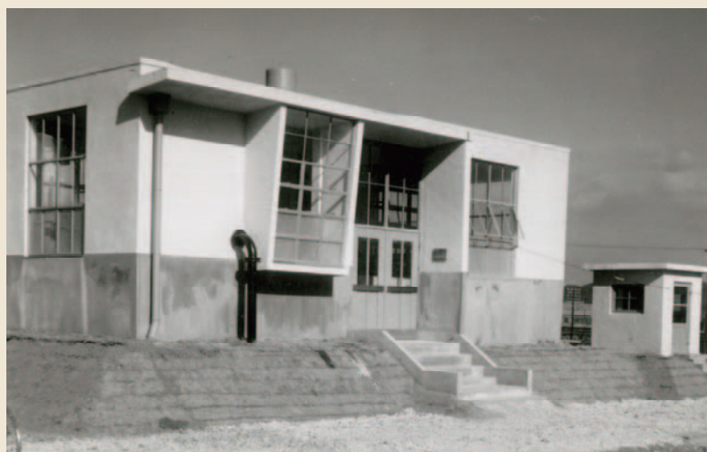
鳥居松浄水場事務所
