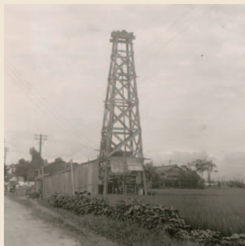
鳥居松町・鳥居松浄水場水源の試験掘現場
