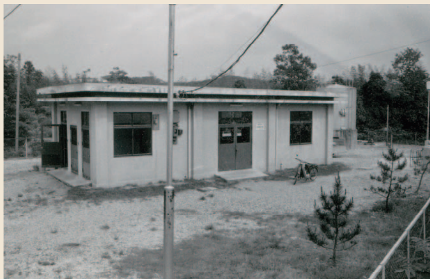
神屋町・坂下浄水場
