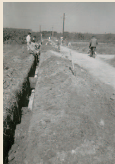
瑞穂通・上水道本管布設
