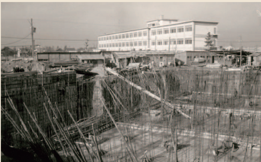
鳥居松町・鳥居松配水場 配水池増設施工状況
