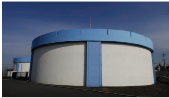
東山町・東山配水場 配水池 (奥が1号地、手前が2号池)
