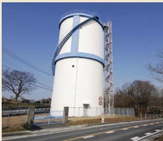
神屋町・神屋西配水場 配水池
