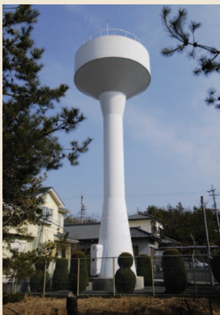
西尾町・春日園配水場 高架タンク
