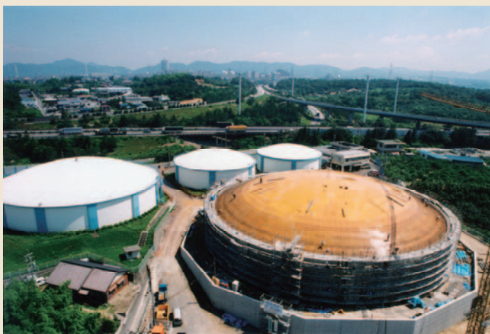
建設中の桃山配水場4号配水池
