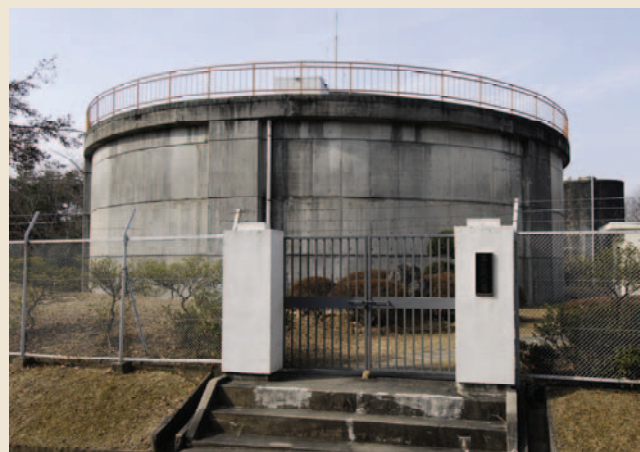
高森台・高蔵寺高区配水場 （平成12年住宅・都市整備公団（現・都市再生機構）より移管）
