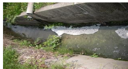
未処理の生活排水が直接放流される側溝
