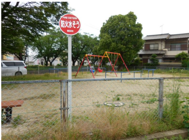
耐震性防火水槽
