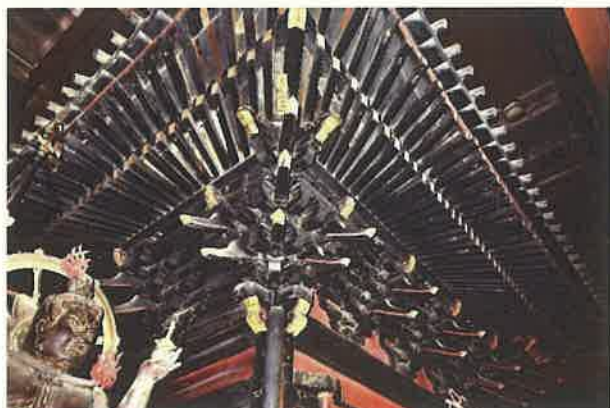
観音堂内厨子 軒見上げ
