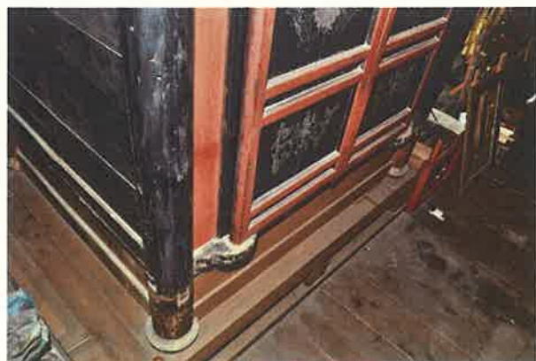
観音堂内厨子 正・側面 柱根部
