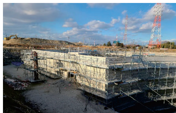
熊野桜佐地区雨水 2 号調整池（施工時写真）
