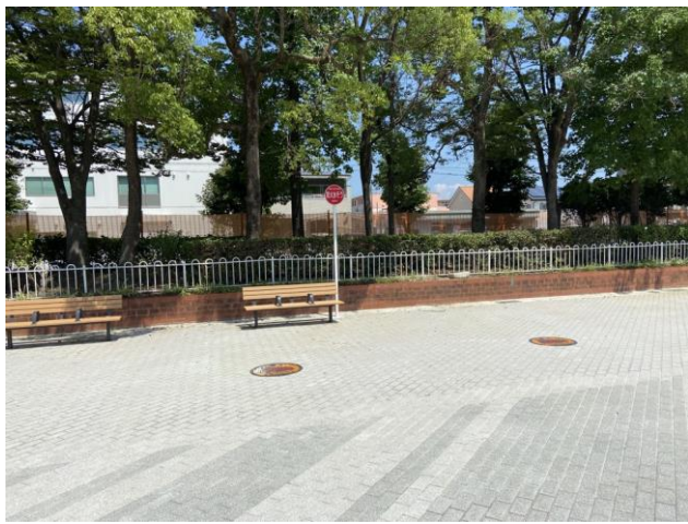
耐震性防火水槽
