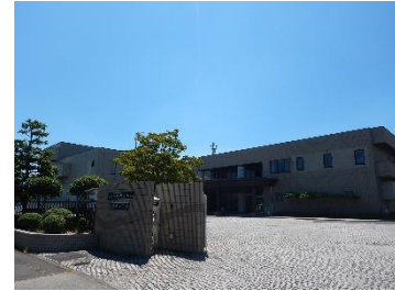
南部浄化センター
