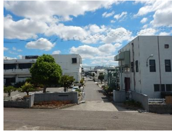
勝西浄化センター
