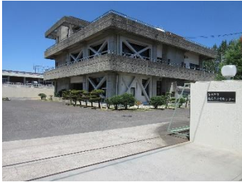
高蔵寺浄化センター
