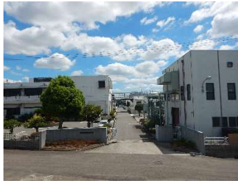
勝西浄化センター
