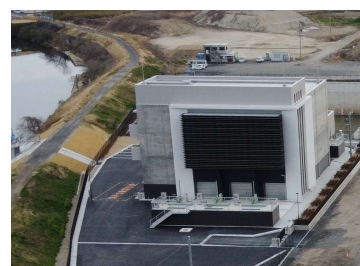
熊野桜佐ポンプ場
