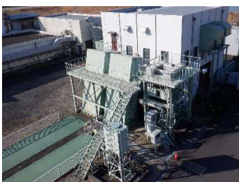
勝西ポンプ場
