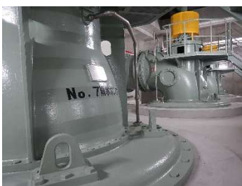
南部ポンプ場
