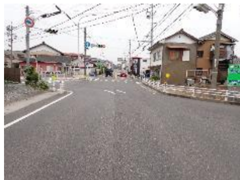
坂下地区排水路
