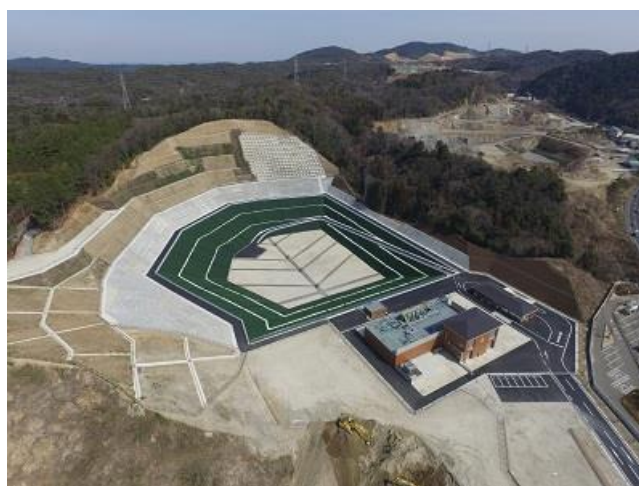
内津北山最終処分場
