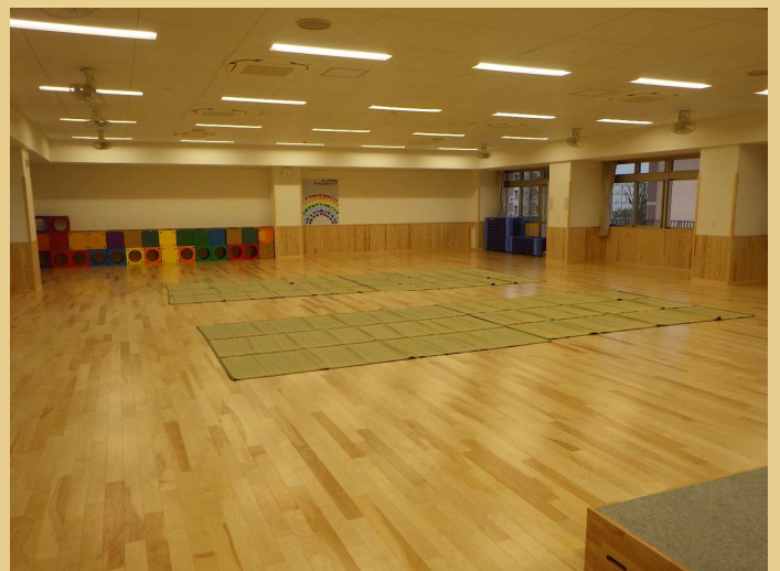
木質化した腰壁とフローリング
