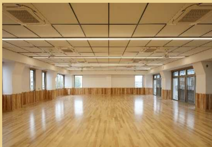
木質化した腰壁とフローリング
