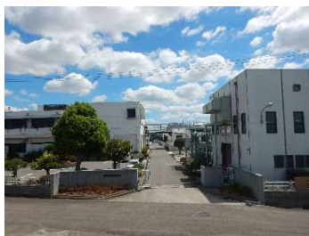
勝西浄化センター
