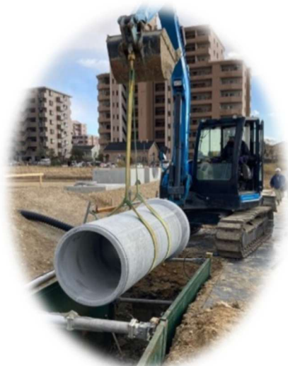
【雨水管渠整備】
