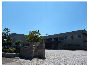
南部浄化センター
