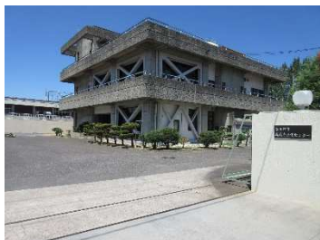
高蔵寺浄化センター
