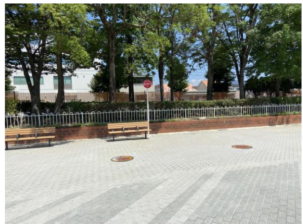
耐震性防火水槽
