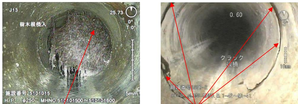
↑管きよの接合部より、木根が侵入している。 ↑管きよの周囲にクラックが入っている。
