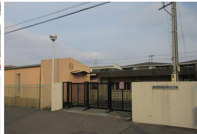
第1汚水中継ポンプ場
