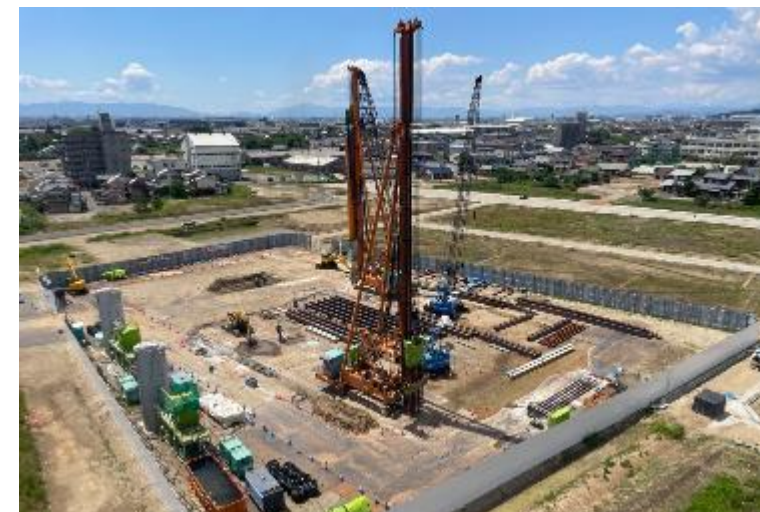
雨水調整池工事
