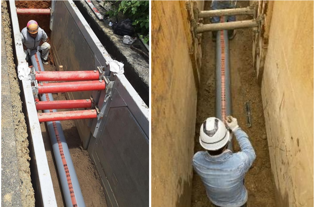
污水管渠工事
