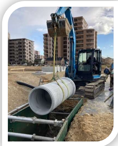
【雨水管渠整備】
