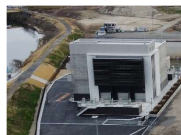
熊野桜佐ポンプ場
