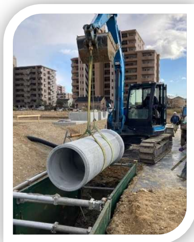
【雨水管渠整備】
