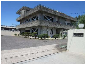
高蔵寺浄化センター
