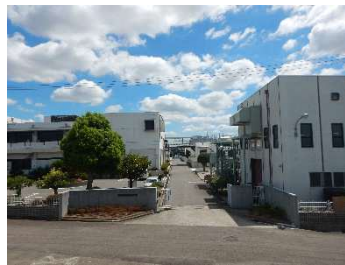
勝西浄化センター
