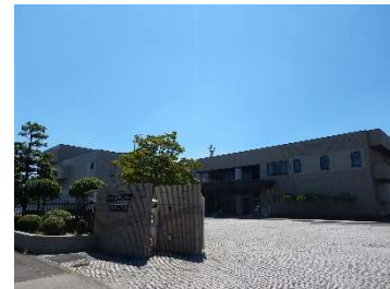
南部浄化センター
