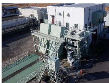
勝西ポンプ場
